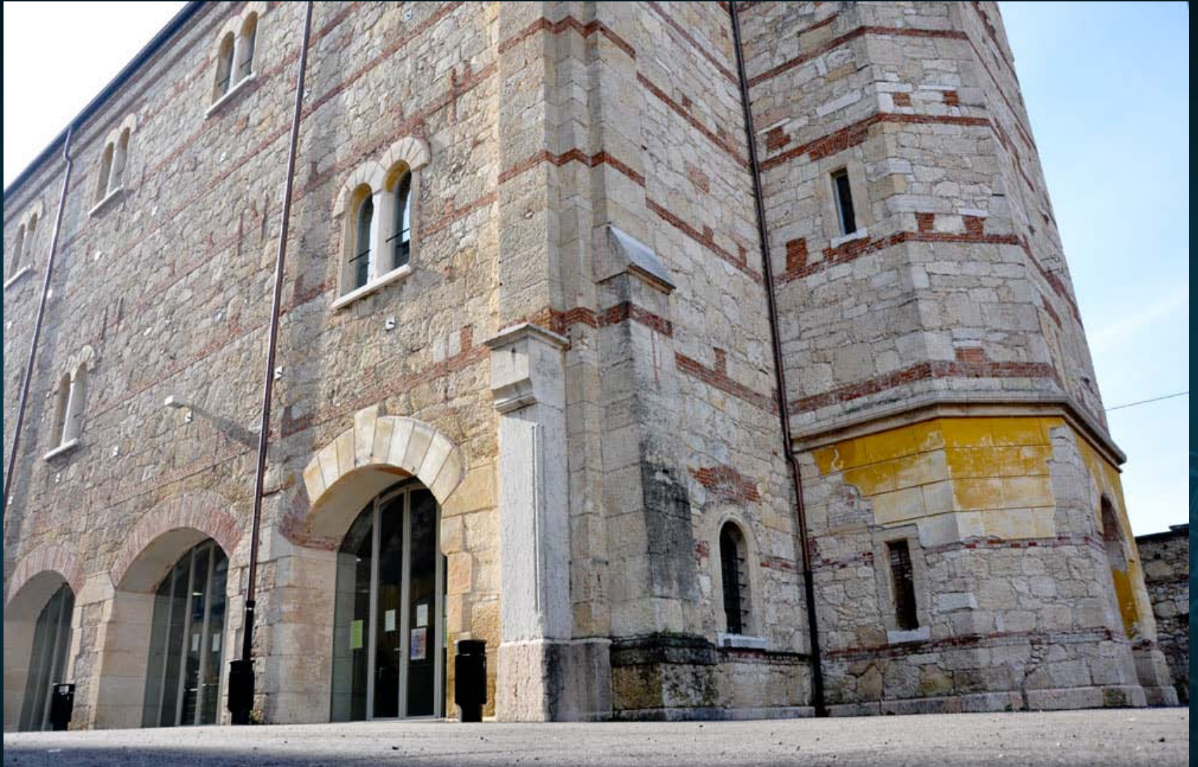
Silos di Ponente
