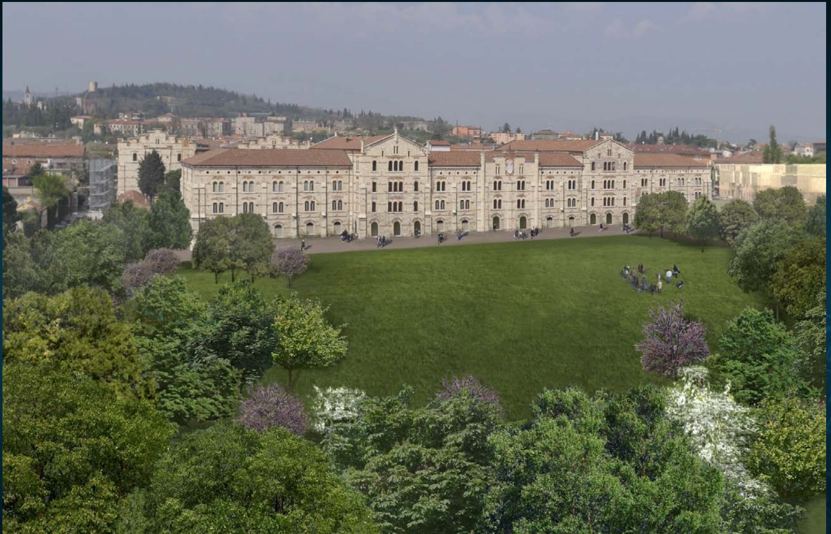
Ex Panificio di Santa Marta - lato sud verso Via Torbido
